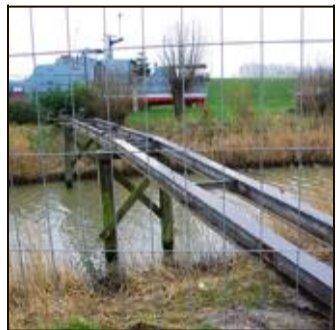
Die Brücke in Höhe des KW19 wird jetzt wiederhergestellt. FOTO: GRABHORN
